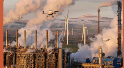
Petrol ve Gaz Boru Hattı Denetimi
